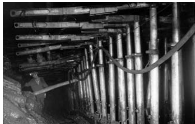
■ Poruby jsou díky programu POP 2010 vybaveny výztužemi s vyšší nosností při zajišťování nadloží. To má pozitivní dopad na bezpečnost práce
