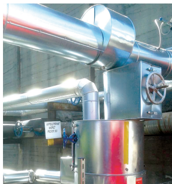
Rekonstrukce rozvodů pro trubkovou pec
