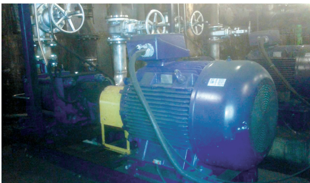
Čerpadlo hydroinjektáže včetně příslušenství
