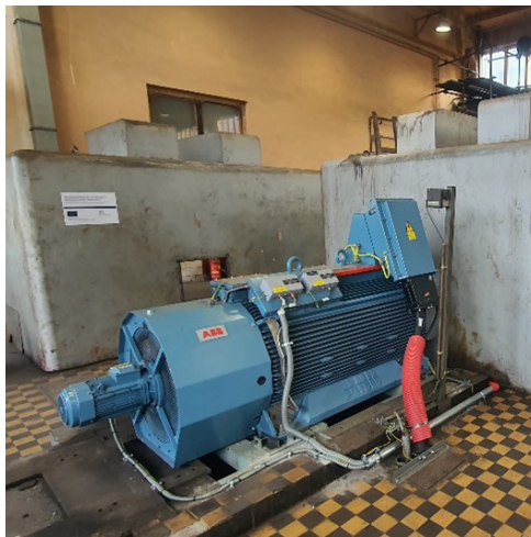
Rekonstrukce pohonů turbodsávačů
