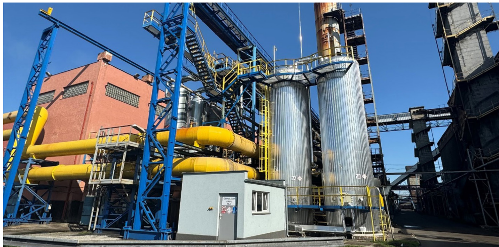
Modernizace deamonizační stanice a zásobníku louhu na čpavkárně
